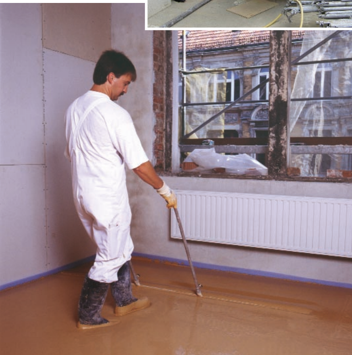
Entlüftungsvorgang mit der Schwabbelstange
