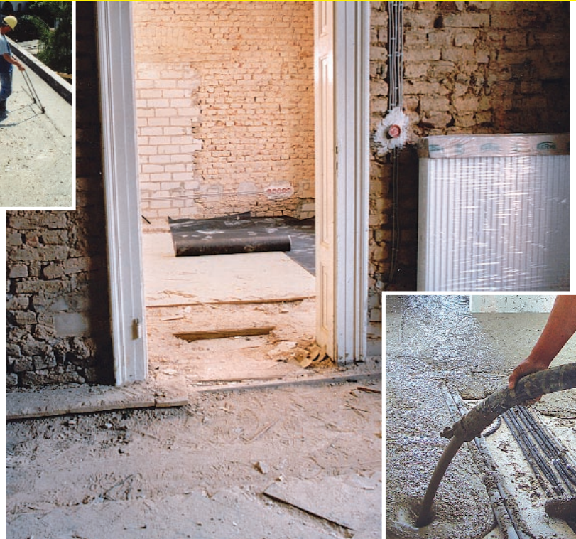
Porenleichtbeton schafft saubere und glatte Flächen als Untergrund für den Estrich
