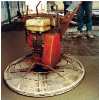
Flügelglätter: SFB Stahlfaserbeton lässt sich mit allen üblichen Geräten und Techniken verarbeiten.
