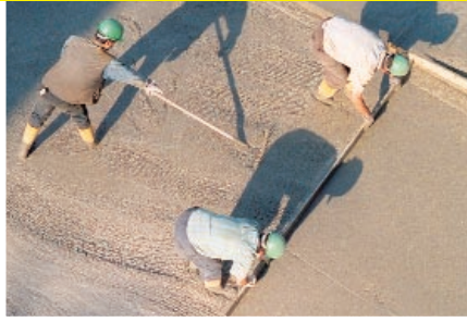
Einbau und Glätten einer Bodenplatte
